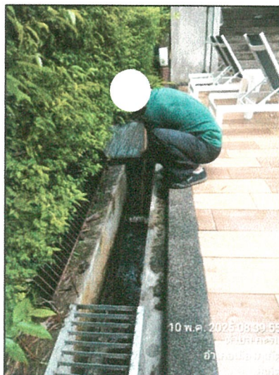
รูปภาพที่ 2.34 การขุดลอกตะกอน
